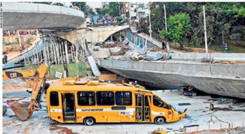
Cenário da tragédia. O ônibus e o carro particular amontoados na queda do viaduto e em construção em Belo Horizonte deixaram seis feridos e dois mortos.
