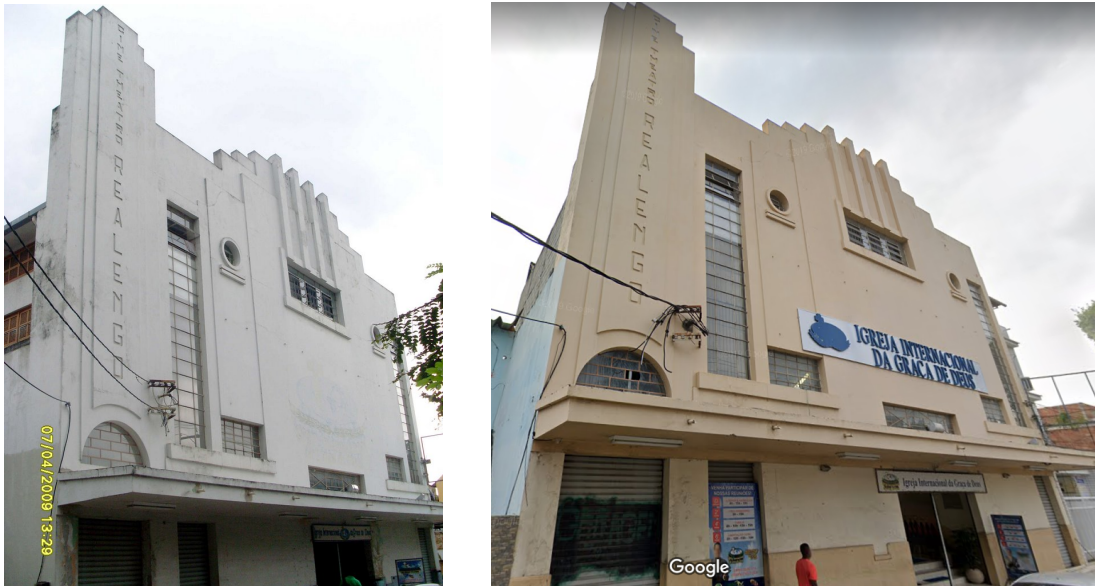
Figura 3 - (esq.) Cine-Theatro Realengo em 2009; (dir.) Cine-Theatro Realengo em 2009 (Google maps)
