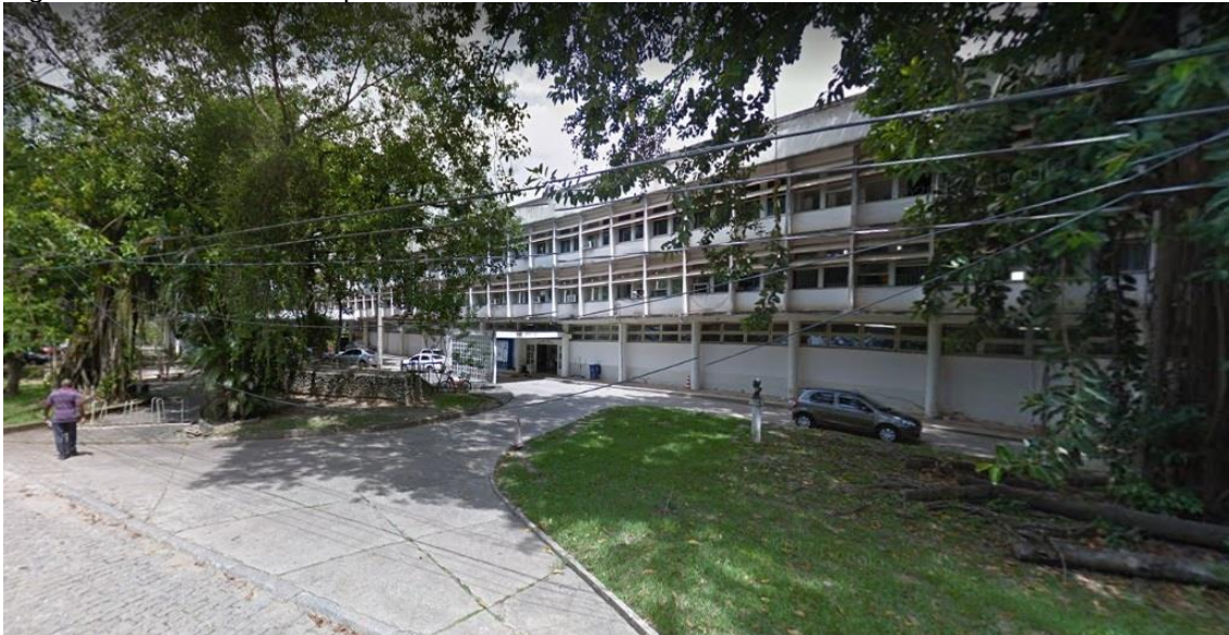
Figura 3. Vista externa do prédio do MBRAC
