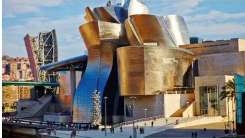
Figura 6 - Museu Guggenheim de Bilbao, Espanha.
