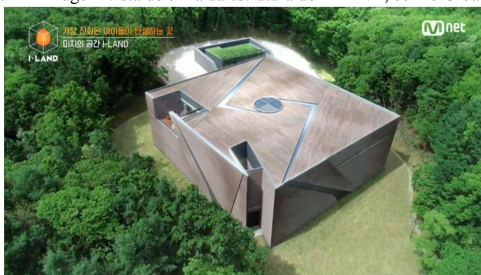
Figura 11 - Imagem vista de cima da estrutura do I-LAND, com o Ground atrás
