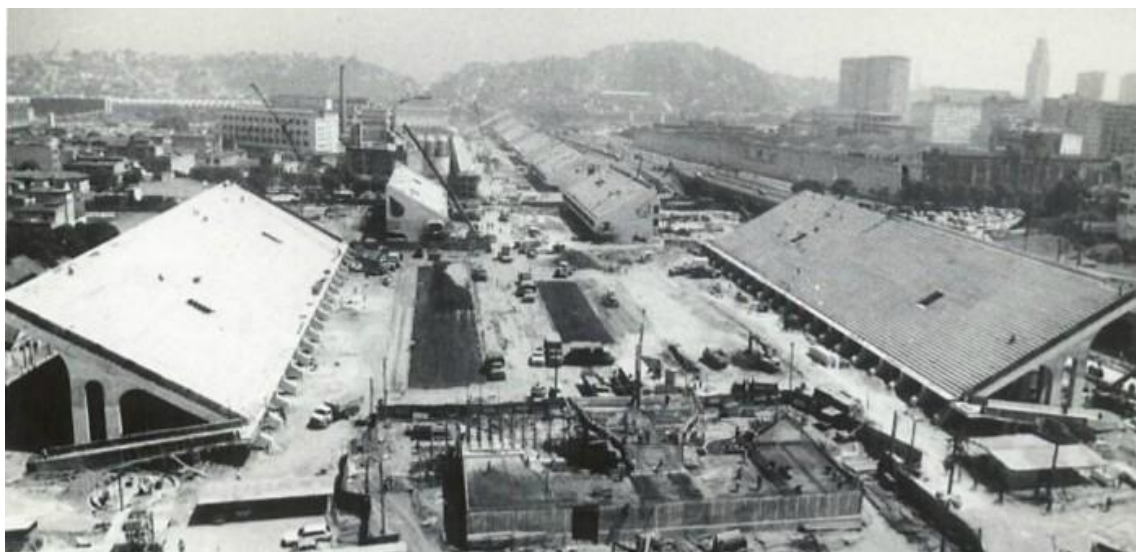
Figura 1 – Sambódromo em construção
