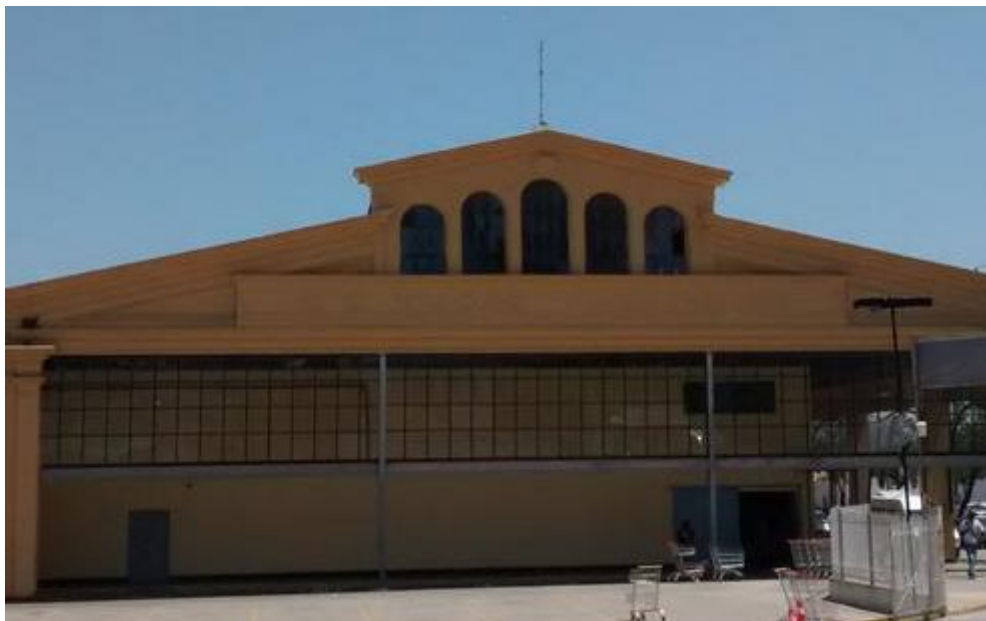
6 - Faixada do Centro Cultural Abrigo dos Bondes – Visualização voltada para o fluxo que vai subir a ponte Rio – Niterói e entrada principal do Centro Cultural.
