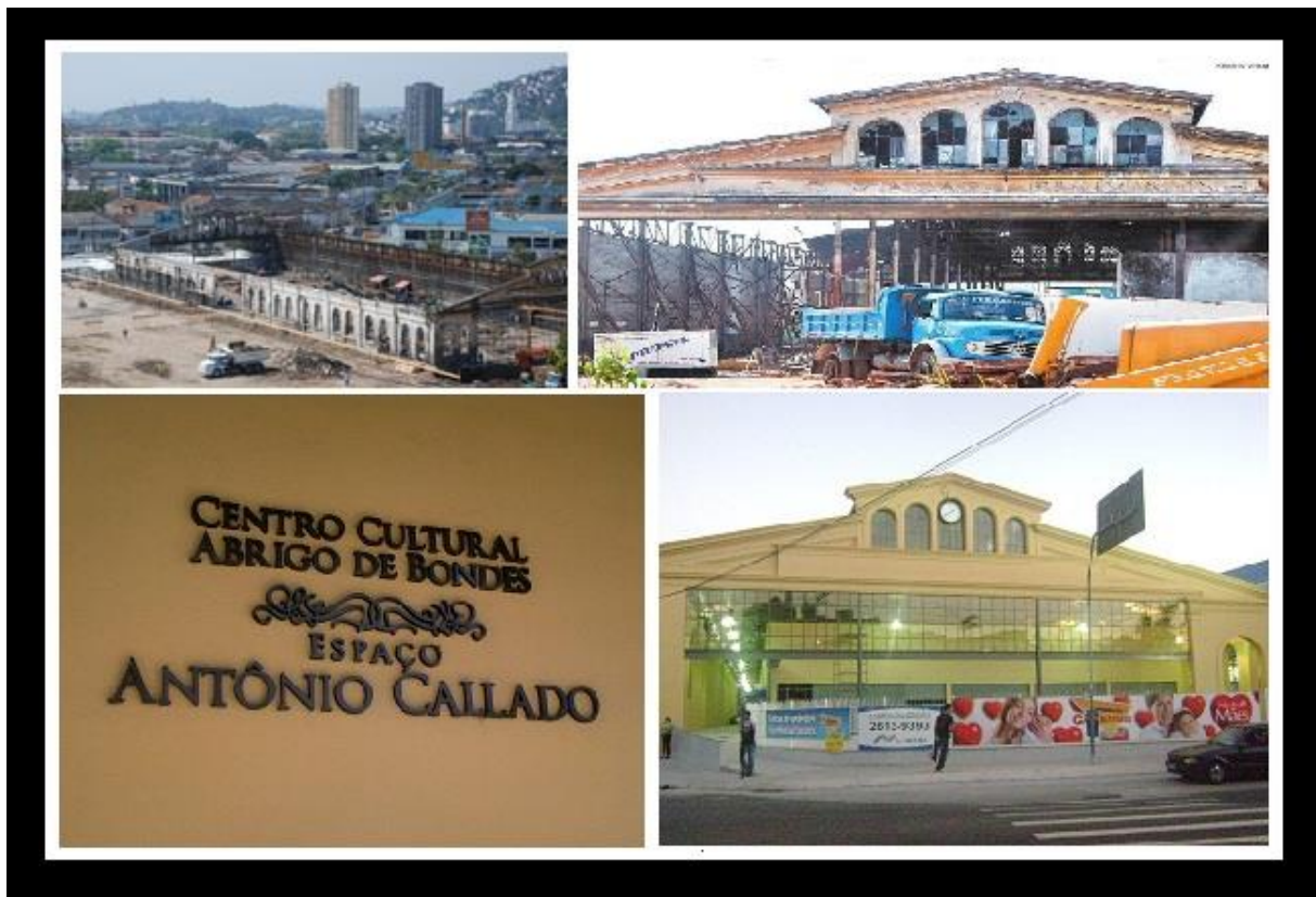
5 - Processo de reforma do Centro Cultural Abrigo dos Bondes
