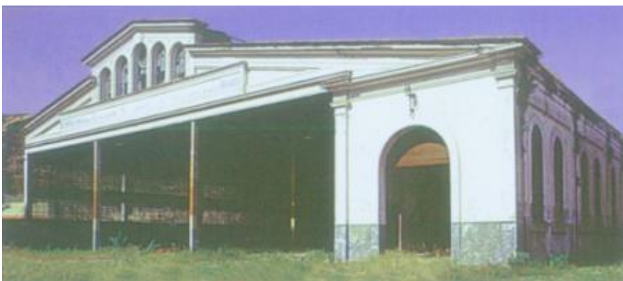
2 - Espaço ainda sendo utilizado como garagem de bondes
