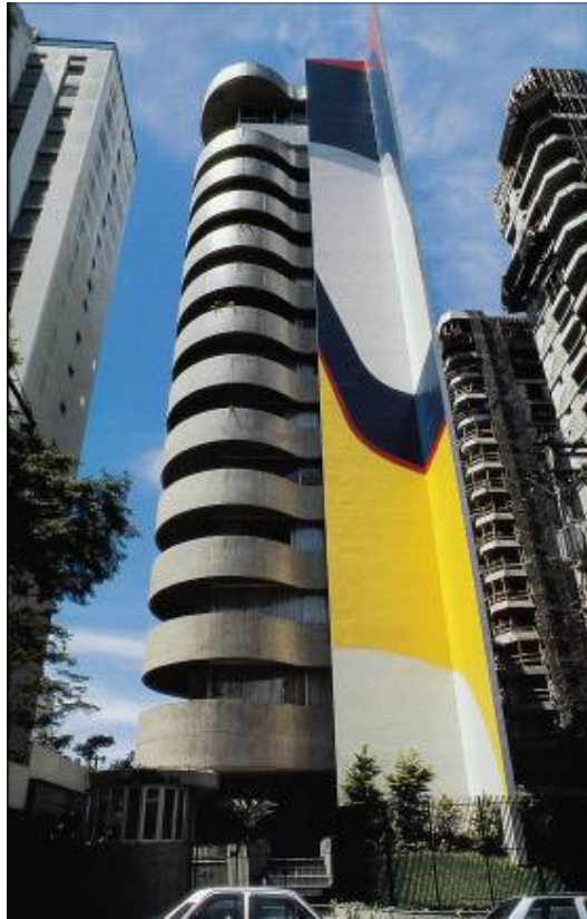
59. Edifício Tomie Ohtake 184
