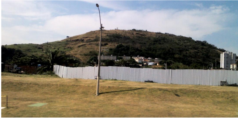
Figura 11: Cercado de construção da Igreja Batista. Fonte: Foto do Autor.
